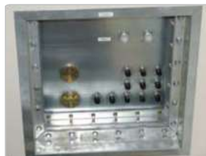
Проходная панель с рамкой С-типа
