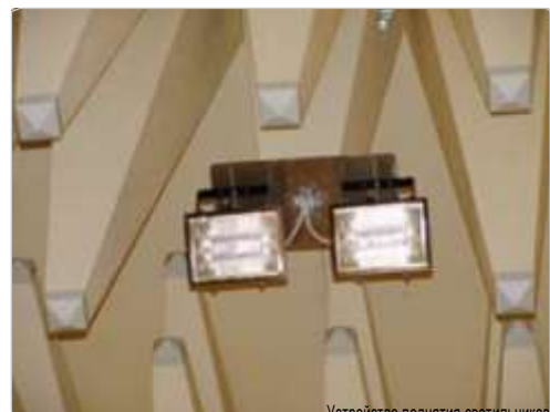
Устройство поднятия светильников
