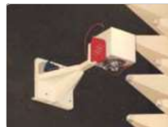
Установленная на стене камера в защитном кожухе для контроля беззвонной камеры
