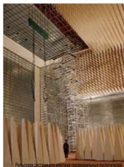
Рельсовая система для монтажа пирамидальных поглотителей
