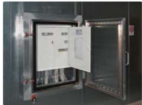
Доступ к электрическому распределительному шкафу с наружной стороны
